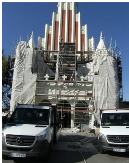
Dépose des filets de protection et démontage de l'échafaudage
