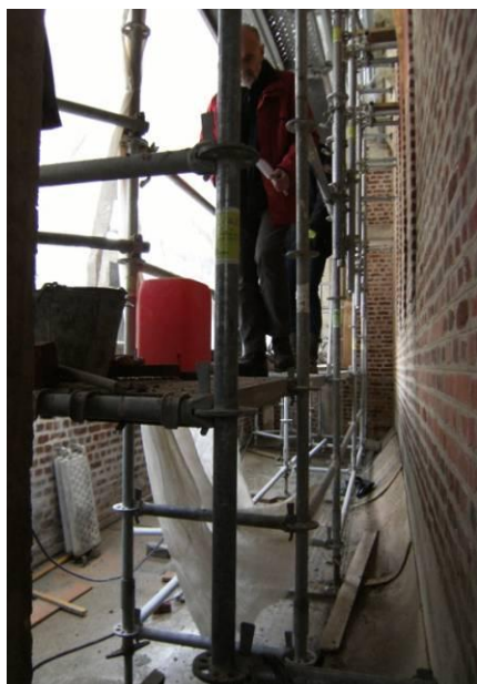
Pose d'un échafaudage sur la terrasse pour la fixation des vitraux en façade
