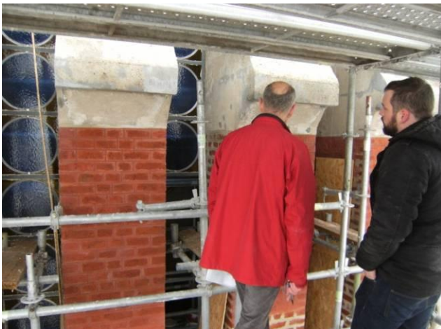
L'architecte Eric BARRIOL observe les étanchéités proposées par le couvreur
