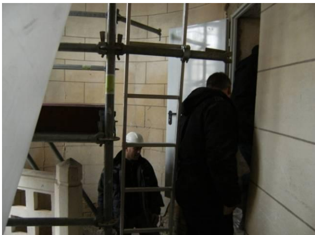
Percement d'une porte pour accès à la terrasse permettant son entretien.
