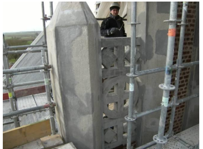
Les claustras qui ont été fabriqués sur place, sont positionnés entre les éléments porteurs.
