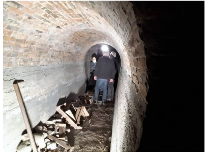
Le souterrain datant de la Seconde Guerre Mondiale se trouve toujours en parfait état, soubassement en béton armé et voûte en briques.
