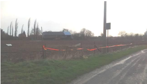
La gendarmerie est intervenue pour la sécurisation, rue du 19 mars 1962, suite à la rupture d'un câble électrique lors de la tempête de février 2020
