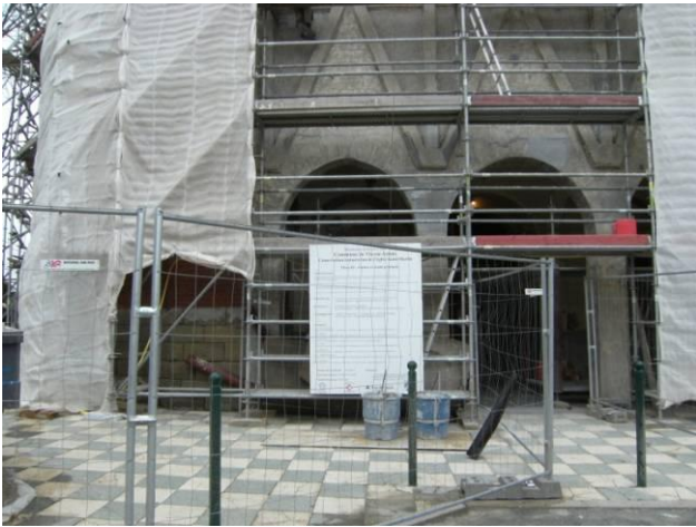
Rénovation des bétons de la façade avant de l'église
