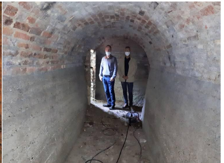
Le souterrain datant de la Seconde Guerre Mondiale se trouve toujours en parfait état, soubassement en béton armé et voûte en briques.
