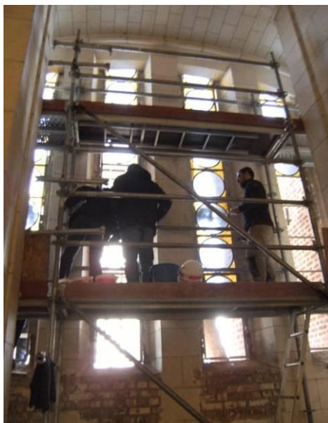
Un échafaudage a été dressé à l'intérieur pour la pose des vitraux.
