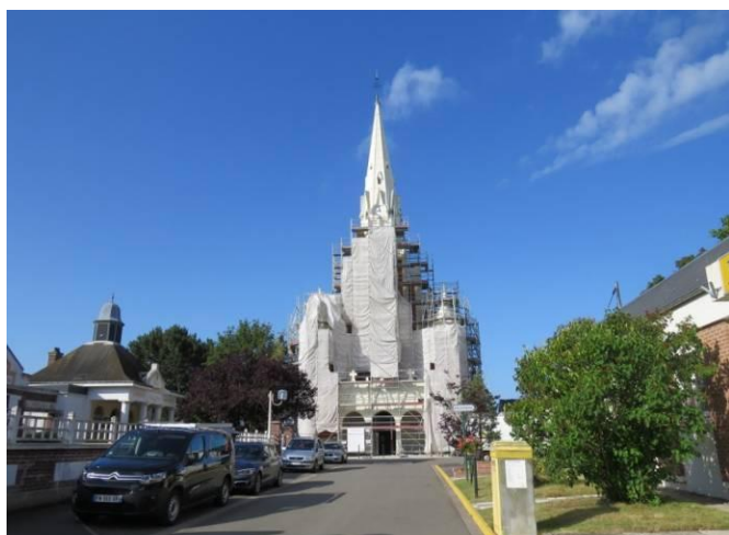
Dépose des filets de protection et démontage de l'échafaudage
