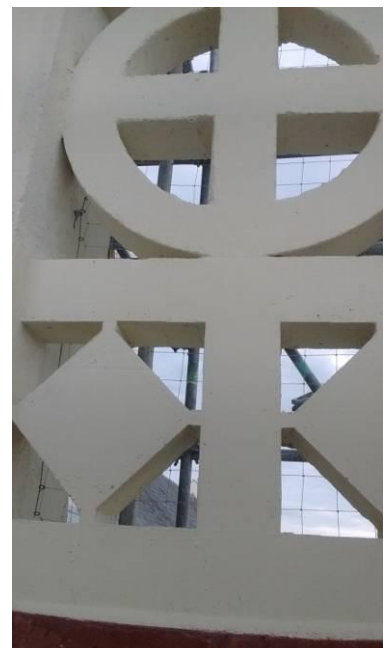
Les claustras qui ont été fabriqués sur place, sont positionnés entre les éléments porteurs.
