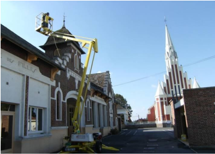
Démoussage, contrôle et réparation de la couverture
