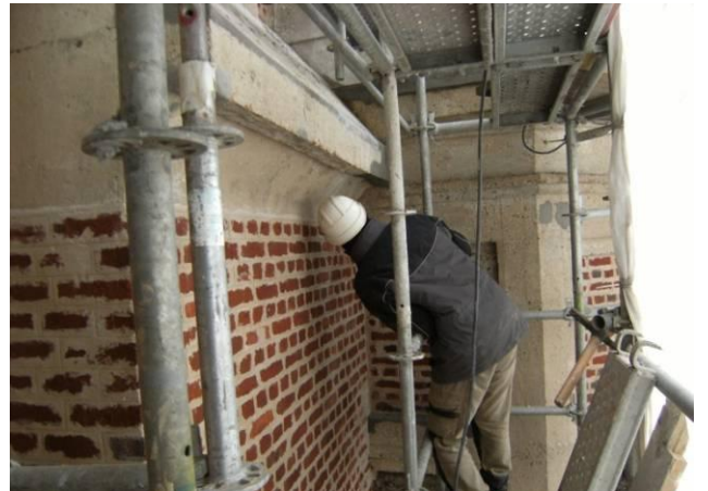
Rejointoiement des briques et réparation des bétons.
