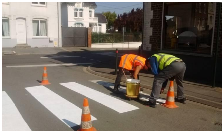
Réfection des peintures des passages protégés.
