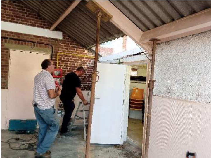
Préau de la salle périscolaire : réfection de la charpente.
