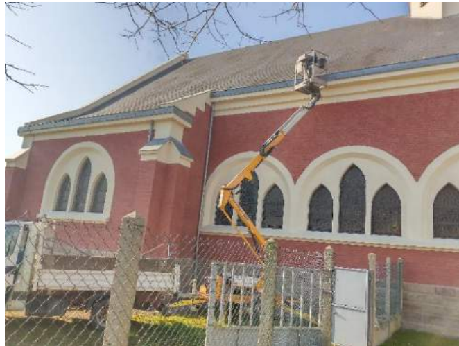
Nettoyage des chéneaux de l'Eglise.
