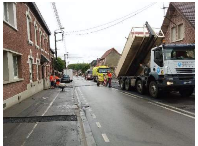
Réfection des enrobés sur une demi-chaussée de la Rue André Mercier et des trottoirs.
