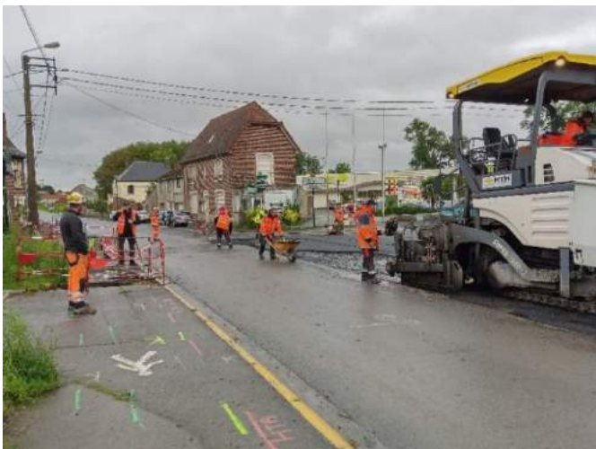
Réfection des enrobés sur une demi-chaussée de la Rue André Mercier et des trottoirs.
