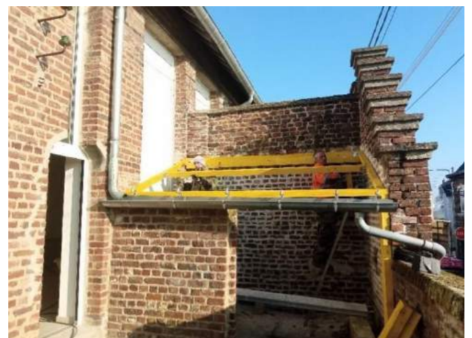
Pose par nos agents communaux d'une nouvelle couverture des bâtiments annexes à l'école.
