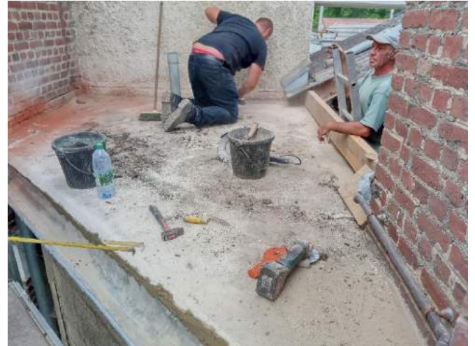
Nouvelle étanchéité de la terrasse, bâtiment entre la mairie et l'école.
