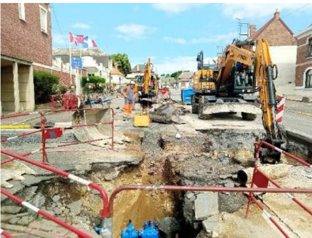
Les travaux d'assainissement et de pose d'une nouvelle canalisation d'eau ont débuté en bas de la Rue André Mercier et se sont poursuivis en remontant jusque l'intersection de la rue de Boiry.
