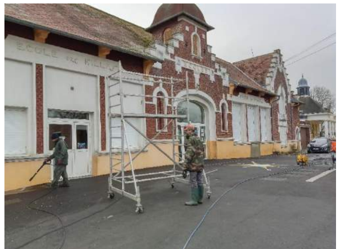
Nettoyage des façades de l'école, après les travaux.
