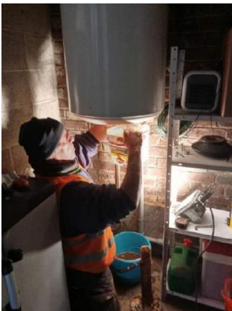
Changement du chauffe-eau par Eric du service technique.
