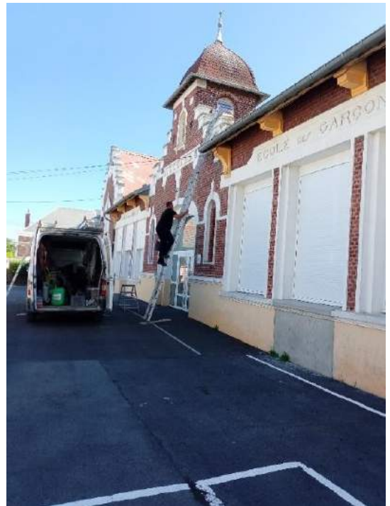
Travaux sur les abat-sons du clocheton de l'école.
