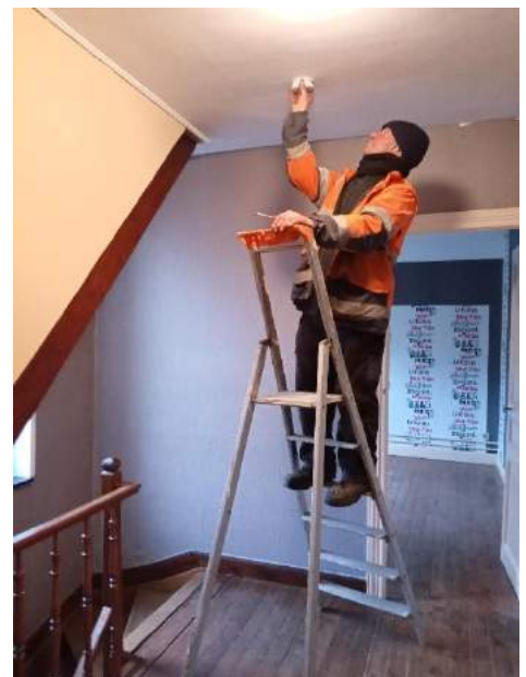
Rénovation du logement 1Place Jules Viseur avant remise en location.
