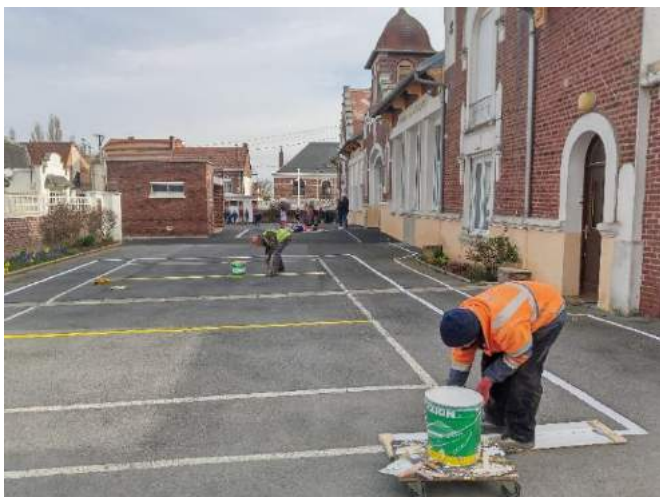
Réfection des marquages au sol dans la cour des écoles.
