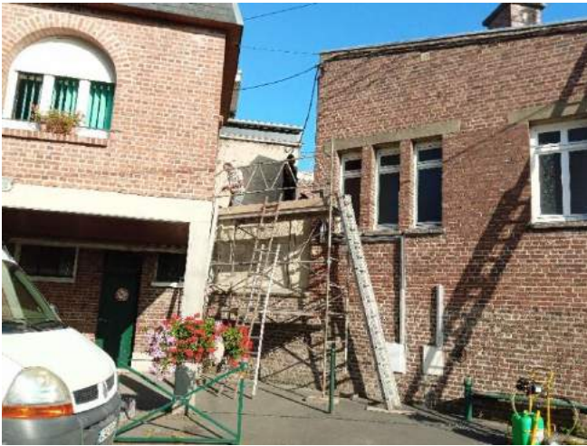
Nouvelle étanchéité de la terrasse, bâtiment entre la mairie et l'école.
