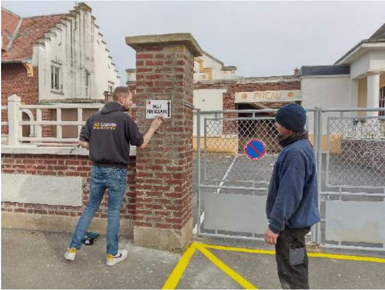
Pose du panneau indicateur de la nouvelle salle périscolaire.
