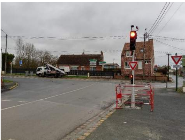
Début des travaux pour l'installation de feux au carrefour des Rues André Mercier, de Rémy et de Chérisy
