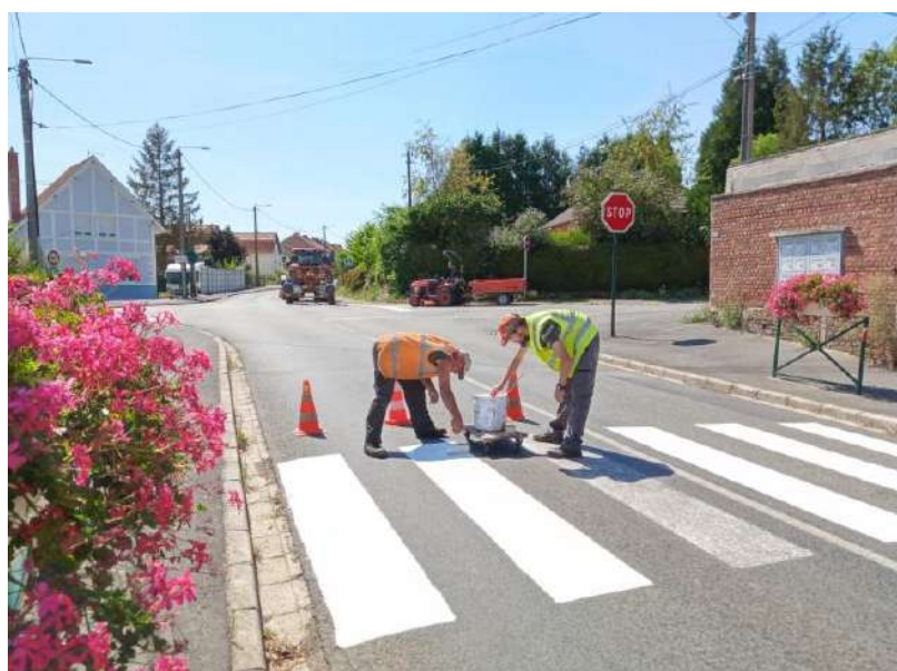
Réfection des signalisations horizontales
