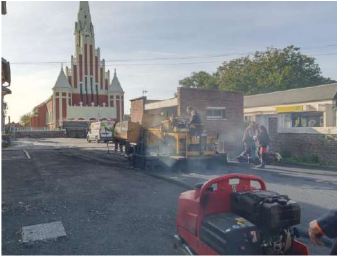
Mise en place du nouveau macadam.
