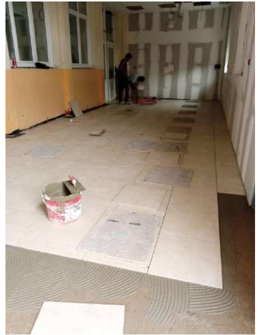
Pose du carrelage
