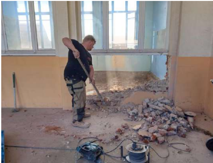
Percement de portes pour communication avec l'ancien préau.
