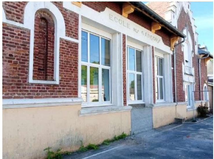
Pose des imposants châssis vitrés avec volets électriques intégrés.
