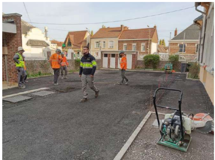
Relevé des regards et mise en forme de la cour avec aménagement d'un accès PMR.
