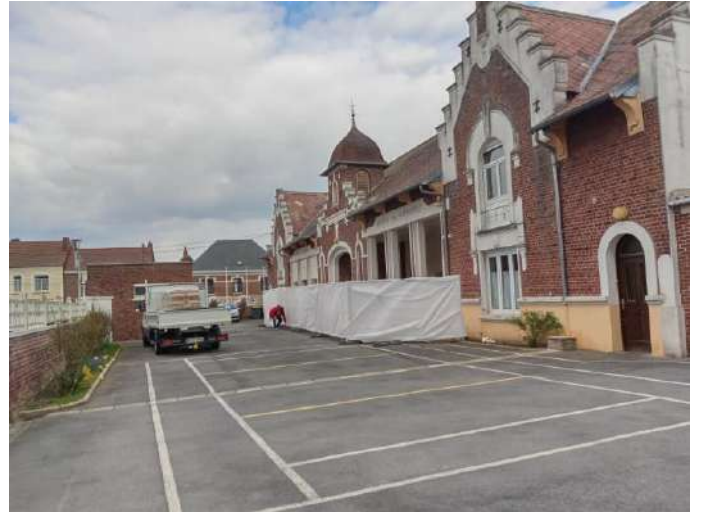
Implantation du chantier avec fermeture extérieure du chantier.
