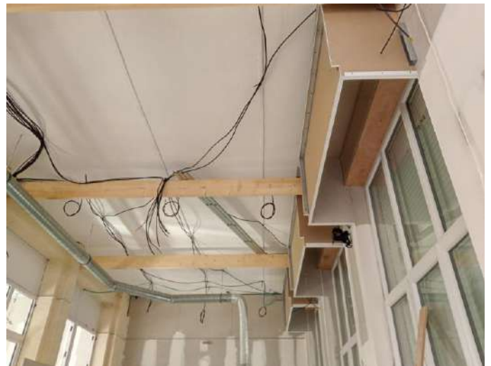
Isolation des murs et plafonds avec isolant recyclé, coordonnée avec les réseaux électriques et informatiques.
