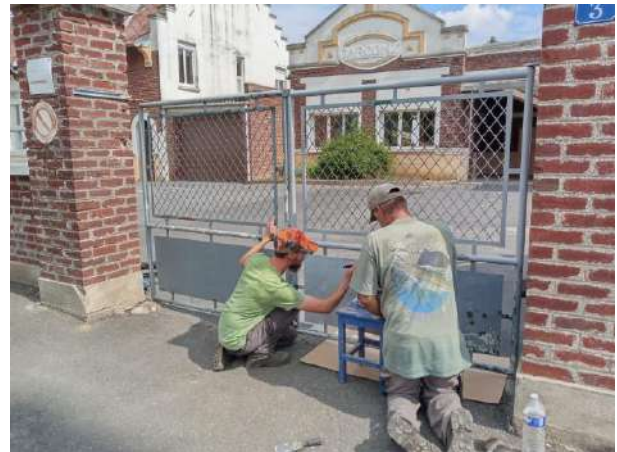
Réfection des peintures des grilles de l'école
