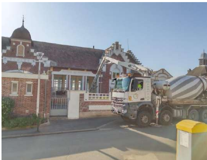
Coulage des dalles par camion équipé de pompe à béton.
