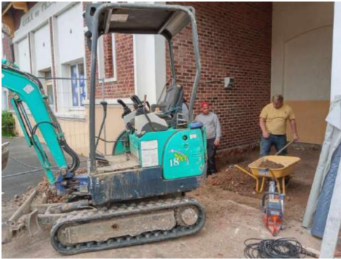
Décaissement de l'ancien préau et pose de canalisation d'assainissement.
