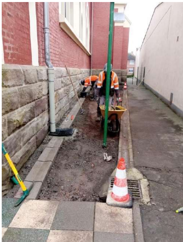
Pose d'un réseau d'eaux pluviales et aménagement piétonnier en macadam entre l'église et la salle polyvalente.
