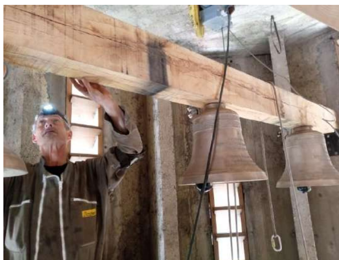
Mise en place des cloches composant le carillon au dessus de la cloche principale.
