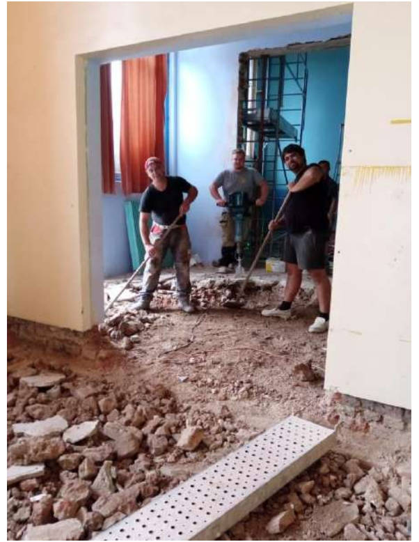
Décaissement des sols pour coulage de la dalle béton. .
