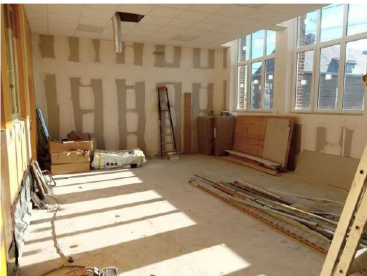
Abaissement des plafonds
