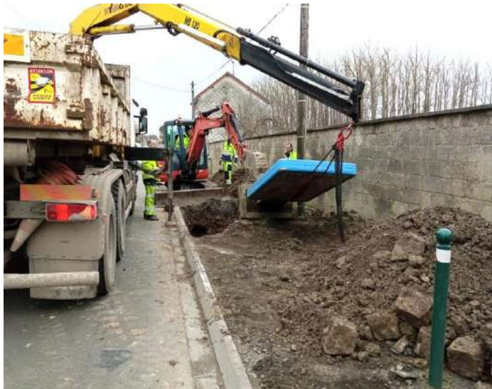
Les nouveaux réseaux d'eau et d'assainissement ont franchi la Sensée et sont en attente de raccordement en trottoir.
