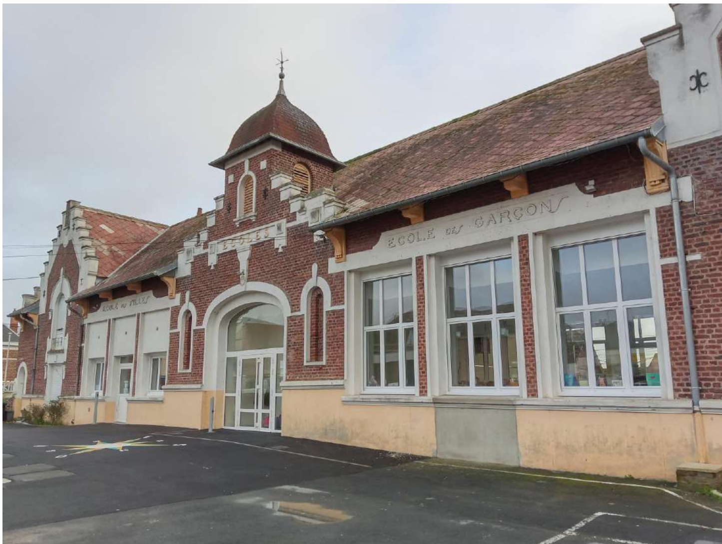
L'école entièrement rénovée et agrandie.
