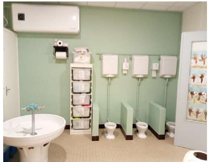
Remise en état des anciennes toilettes avec pose d'un nouveau chauffe-eau
