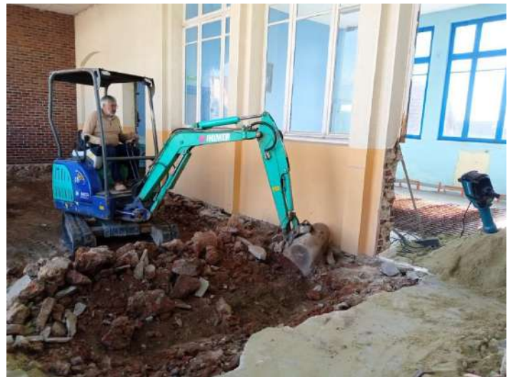
Démolition des dalles béton existantes.
