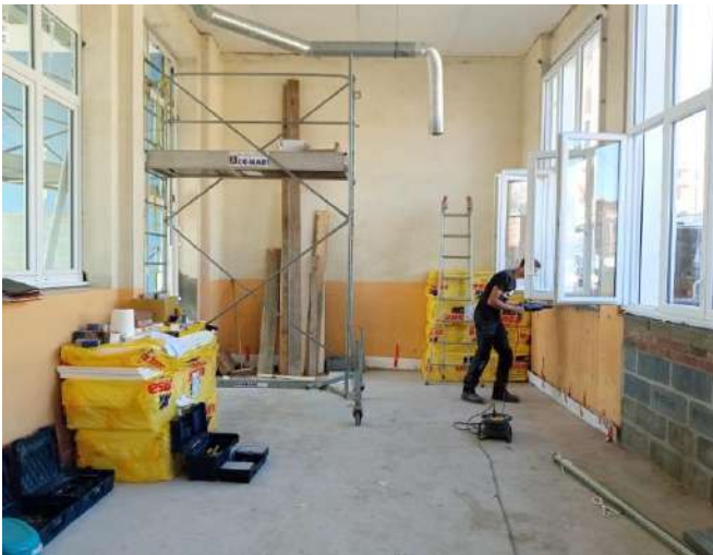
Isolation des murs et plafonds avec isolant recyclé, coordonnée avec les réseaux électriques et informatiques.
