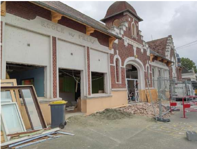
Démontage des anciennes huisseries
