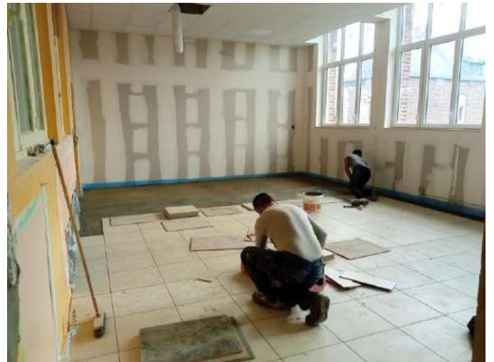
Cloisonnement pour la création du nouveau dortoir et pose du carrelage.
