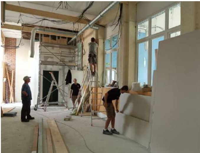
Isolation des murs et plafonds avec isolant recyclé, coordonnée avec les réseaux électriques et informatiques.
