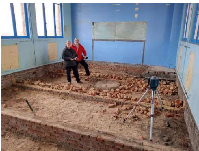
Préparation des sols après enlèvement des anciens parquets.
