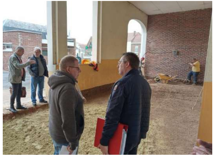
Réunion de chantier sous la direction de l'architecte M. MATUSZAK Eric au premier plan à gauche.
