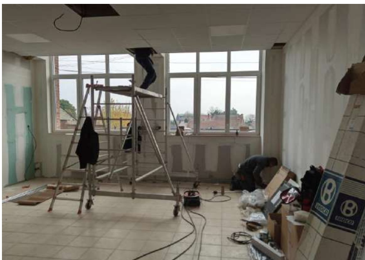
Nouvelle installation électrique.
