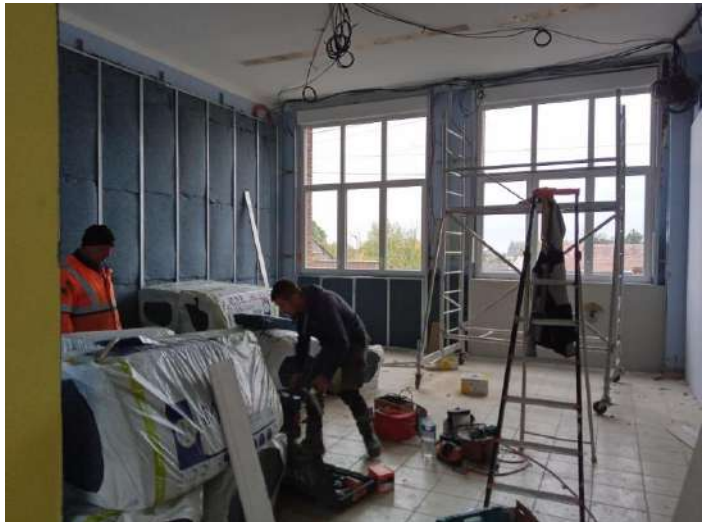
Isolation des plafonds et des murs avec isolant recyclé
