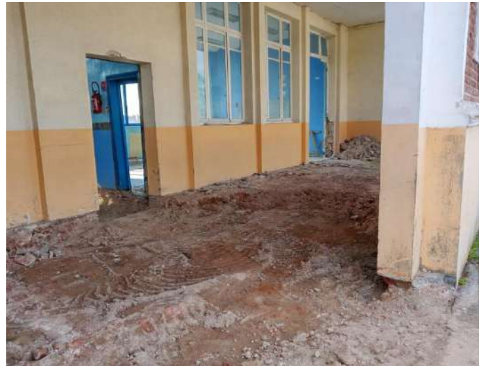
Percement de portes pour communication avec l'ancien préau.
