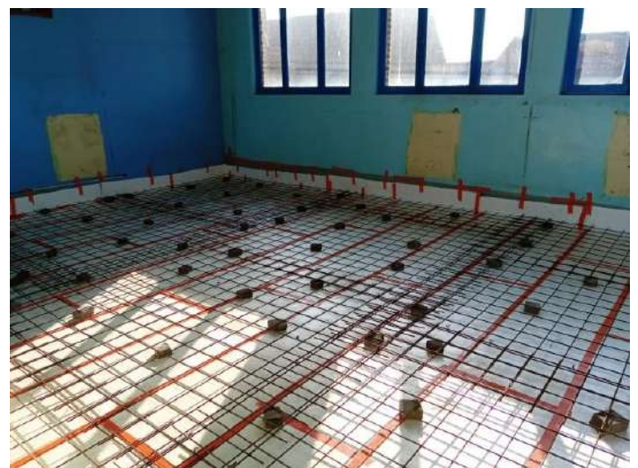
Ferrailage des dalles béton.
