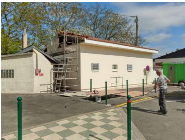
Réfection du pignon et remise en peinture de l'ensemble du commutateur téléphonique par les services de France Télécom.
