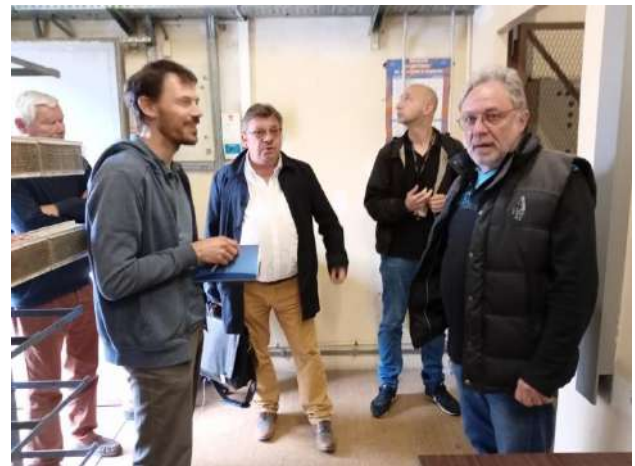
Visite de l'intérieur du commutateur qui voit le remplacement progressif du réseau téléphonique cuivre par la fibre.
