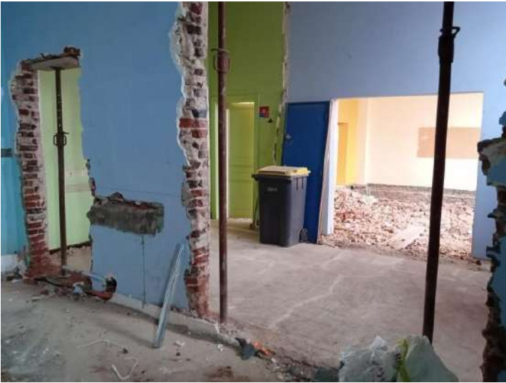
Démolition de murs intérieurs pour agrandissement du dortoir.
