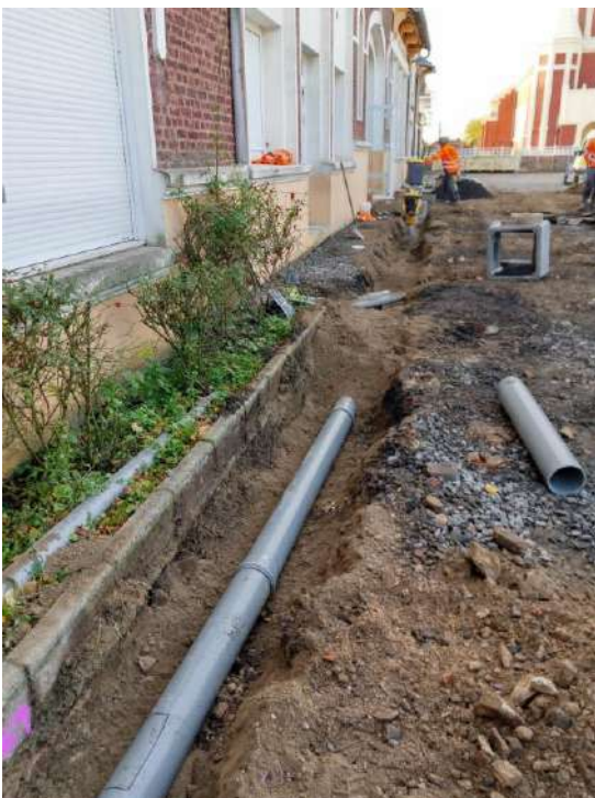
Raccordement du bloc sanitaire intérieur au réseau d'assainissement nouvellement créé au vu d'une connexion au futur réseau public.
