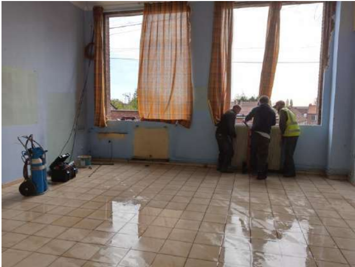
Installation de nouveaux radiateurs.
