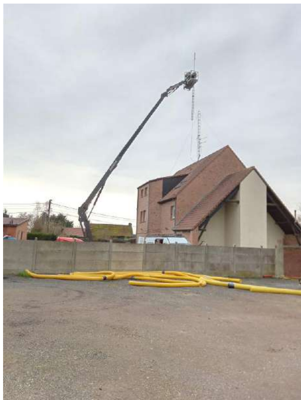
Changement du mât d'antenne de la brigade le 01/03/2022
