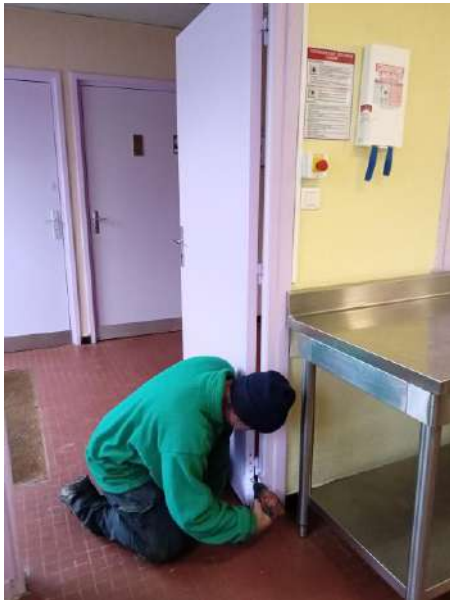
Réfection des bas de portes
