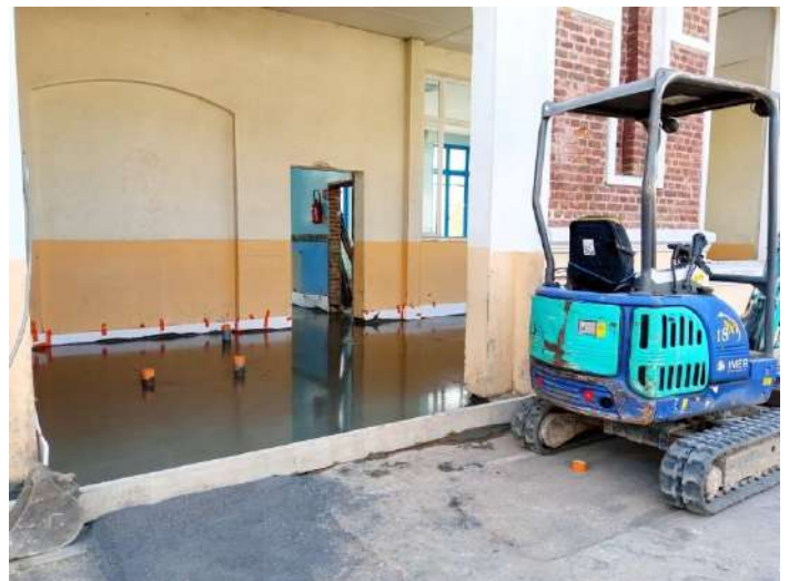
Coulage de la dalle dans l'ancien préau.
