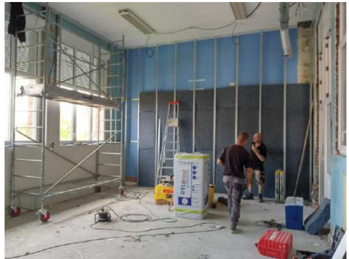
Isolation des murs et plafonds avec isolant recyclé, coordonnée avec les réseaux électriques et informatiques.
