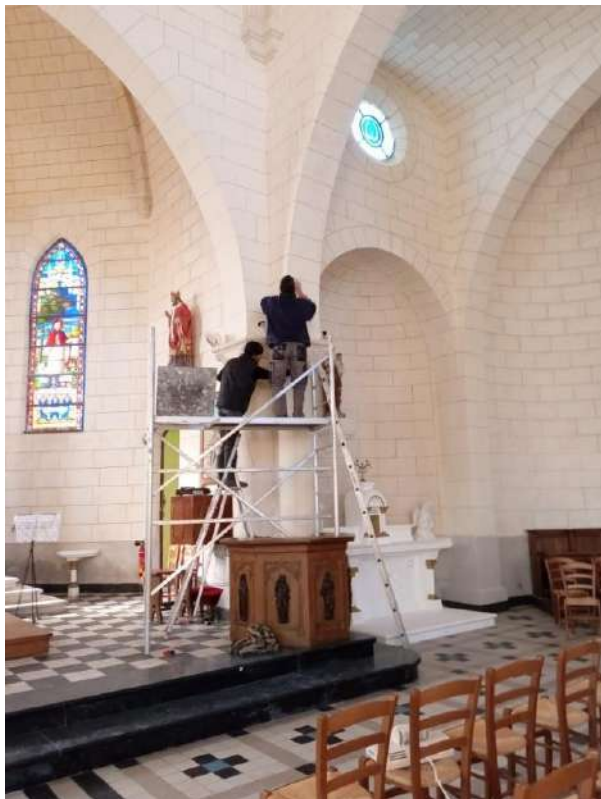
Ajustement des convecteurs de chauffage
