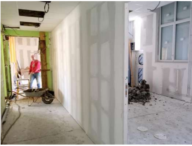
Cloisonnement pour la création du nouveau dortoir et pose du carrelage.
