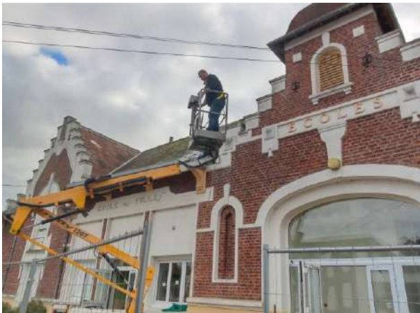
Travaux de démoussage du toit de l'école
