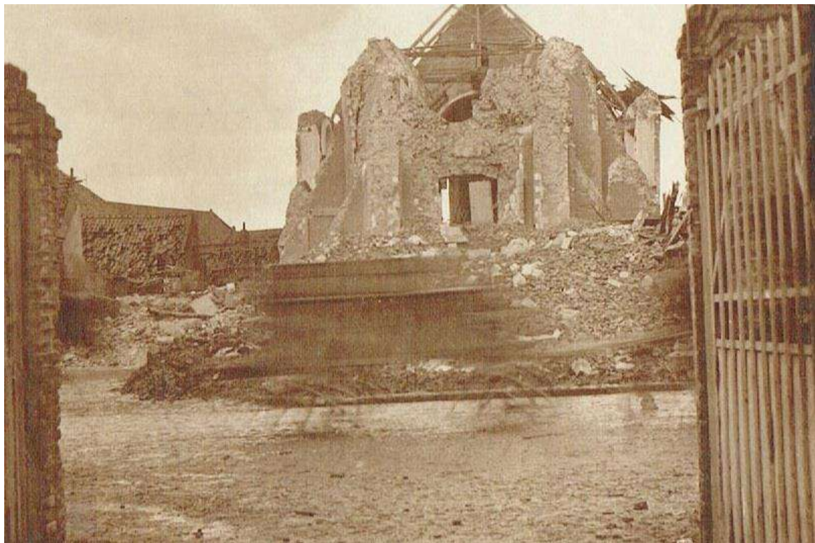
Vue de l'église détruite, à partir de l'escalier d'accès.
