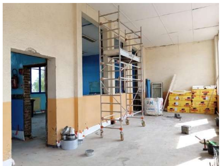
Pose des dalles des nouveaux plafonds.
