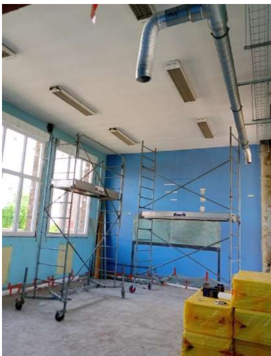
Installation d'une VMC contrôlée avec détection de CO2
