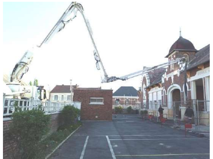
Coulage des dalles par camion équipé de pompe à béton.
