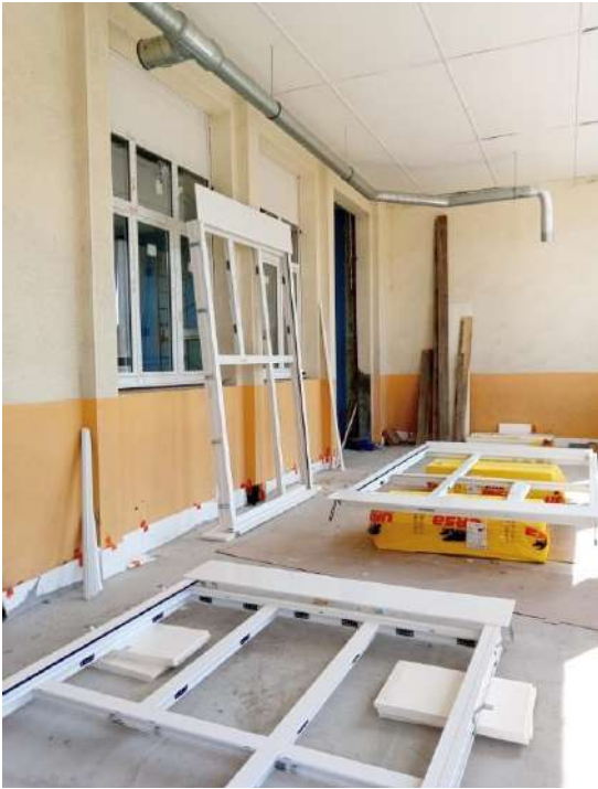
Pose des imposants châssis vitrés avec volets électriques intégrés.
