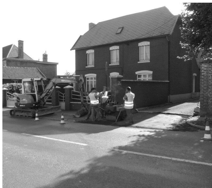
Le profil de la rue neuve a été modifié afin de supprimer la flaque d'eau à son intersection avec la rue André Mercier
