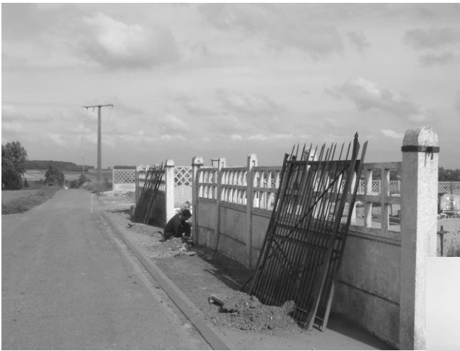
Dépose des anciennes grilles
