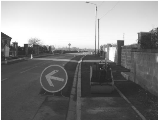
Borduration et réalisation de trottoirs à l'entrée de l'agglomération, rue de Chérisy.
