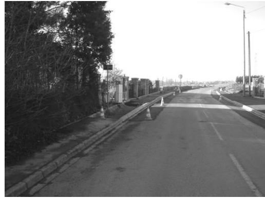
Borduration et réalisation de trottoirs à l'entrée de l'agglomération, rue de Chérisy.
