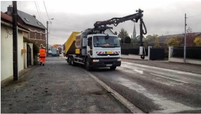
Réfection des déformations sur la RD 939 en agglomération.
