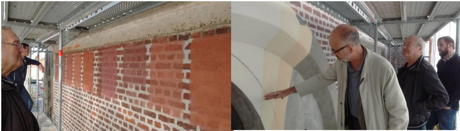
Nuancier réalisé sur les murs pour le choix des teintes du badigeonnage des briques et la coloration des bétons en peinture minérale ;
