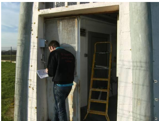
Réparation de l'alarme du château d'eau
