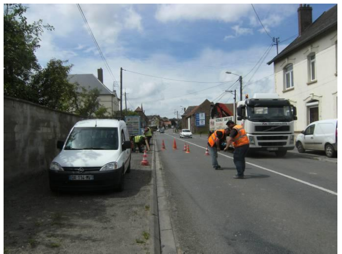
Création d'un nouveau passage piéton, rue André Mercier, à l'entrée de la commune.
