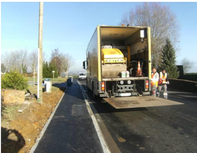
Réalisation en enrobé des trottoirs rue de Boiry
