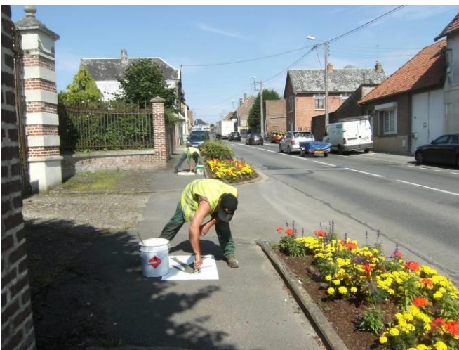
Matérialisation d'un couloir piétonnier
