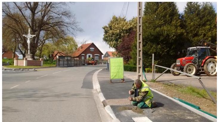
Installation d'équipements urbains le long des nouveaux trottoirs, rue de Boiry, potelets, barrières de sécurité et panneaux de signalisation.
