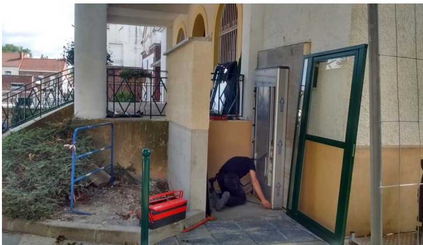
Montage du mécanisme de levage et des ouvrants
