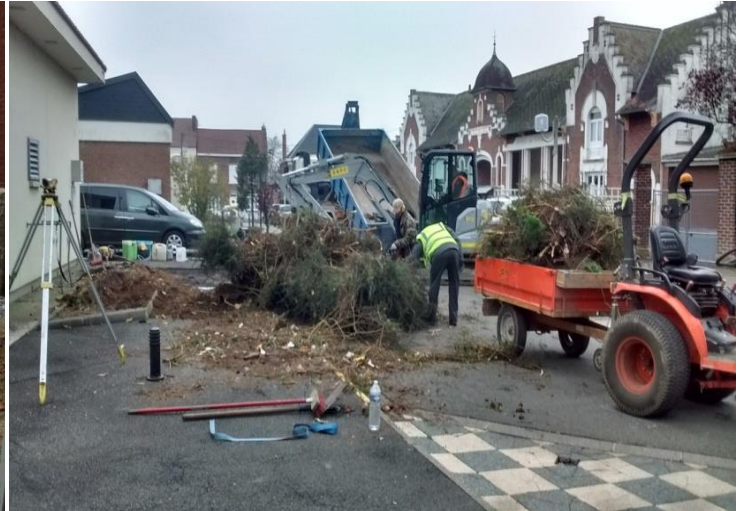
Enlèvement des végétaux pour la réalisation du parking PMR
