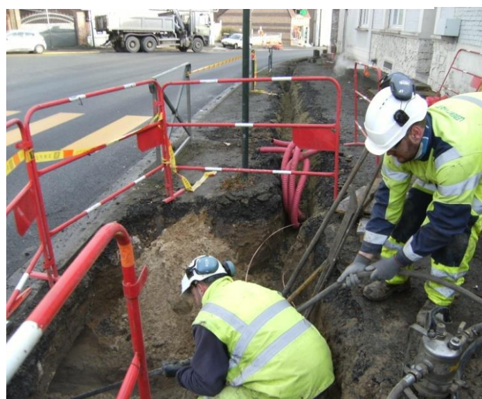
Tranchées pour le passage des fourreaux par forage et aspiration des gravats
