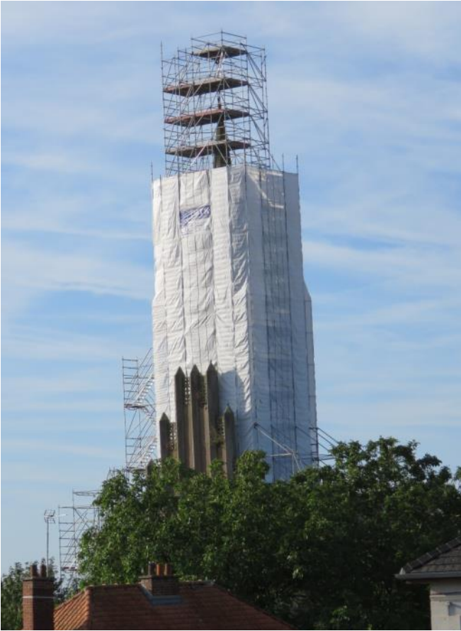
Pose des filets sur l'échafaudage
