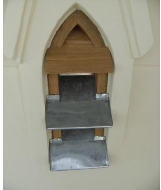
Remplacement des abat-sons et recouvrement en zinc
