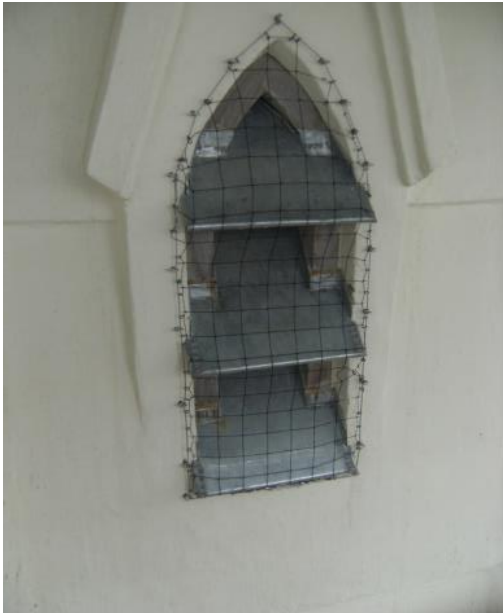
Mise en place des filets anti-pigeons
