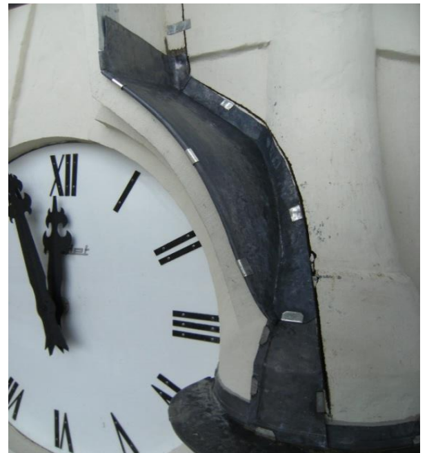
Étanchéité de l'horloge
