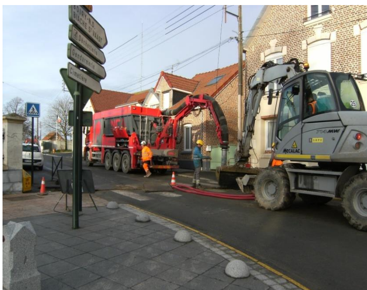
Tranchées pour le passage des fourreaux par forage et aspiration des gravats
