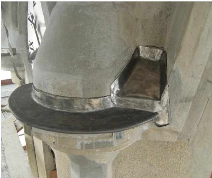
Habillage des bétons en plomb pour une meilleure étanchéité.
