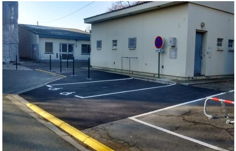
Implantation des nouveaux potelets répondant aux normes PMR.
