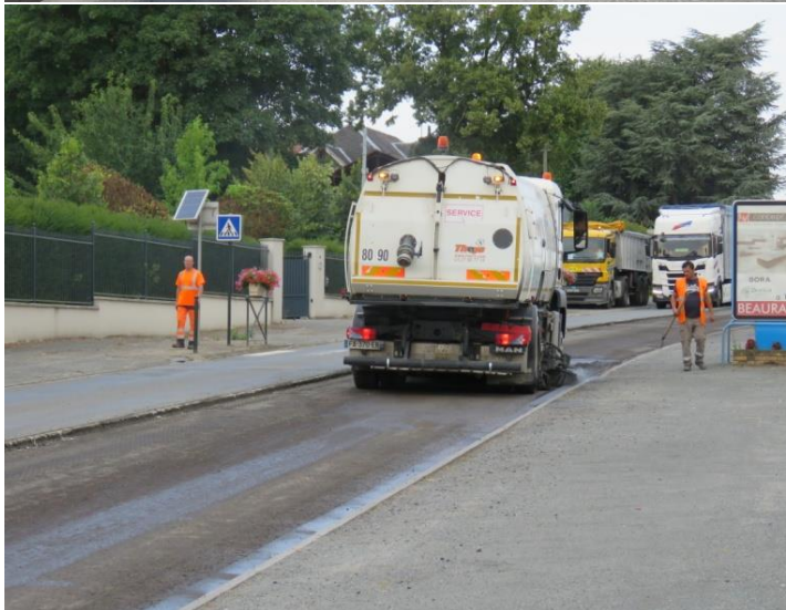
Nettoyage de la chaussée et application de la couche d'accroche par projection de bitume.
