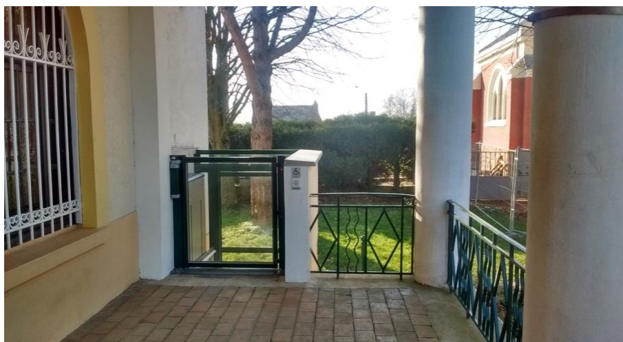
Fin des travaux, portillon côté Mairie et porte côté jardin.
