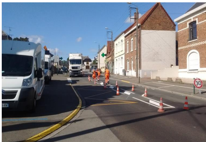
Marquage au sol – signalisation horizontale
