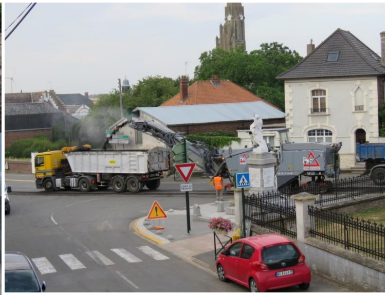
Rabotage de la chaussée
