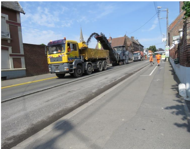
Rabotage de la chaussée
