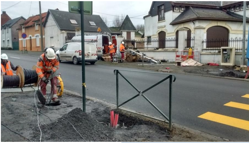
Câblages et installation du coffret de commande
