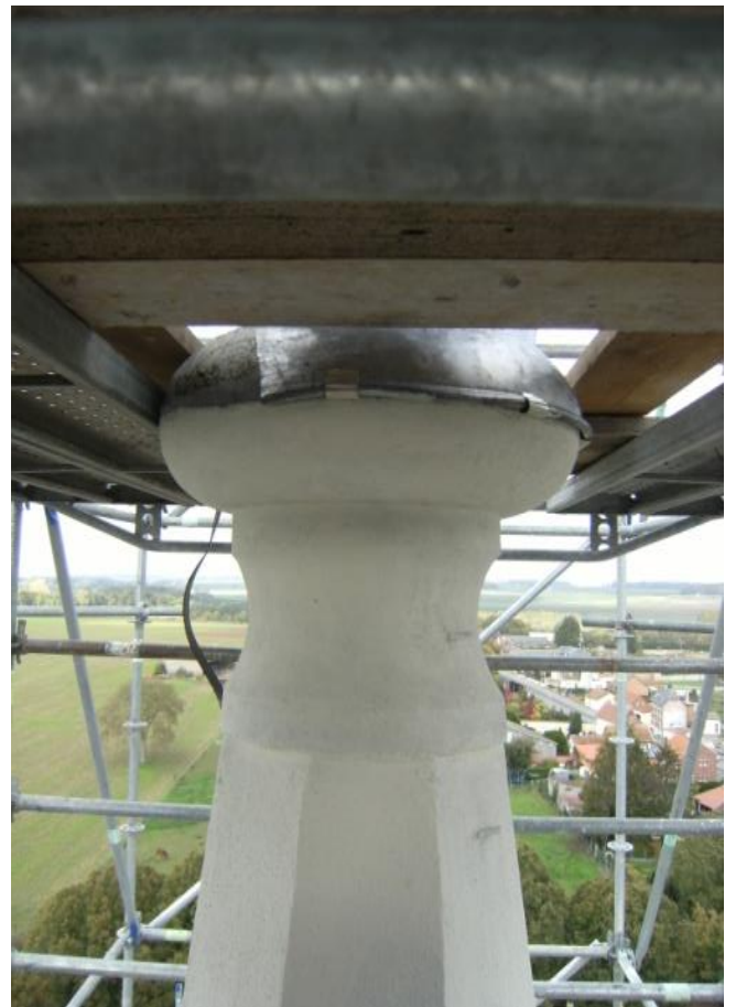
Réfection de la pointe du clocher. Coulage de la forme en béton et façonnage de la calotte en plomb.
