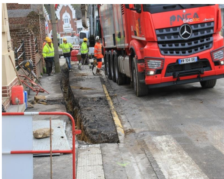
Tranchées pour le passage des fourreaux par forage et aspiration des gravats
