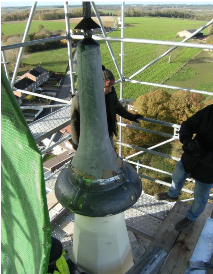
Réfection de la pointe du clocher. Coulage de la forme en béton et façonnage de la calotte en plomb.
