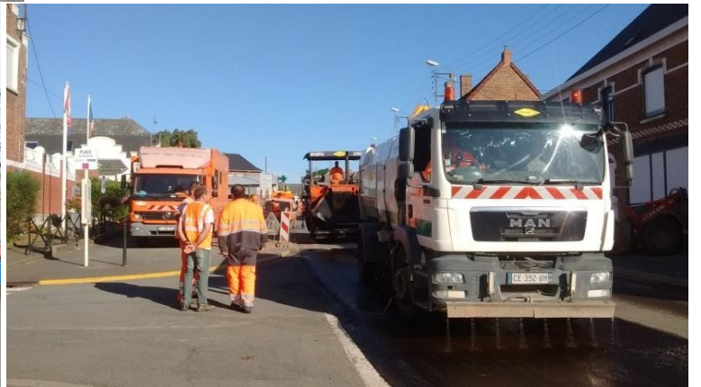
Nettoyage de la chaussée et application de la couche d'accroche par projection de bitume.
