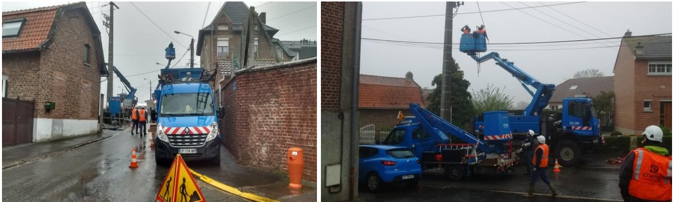
Renforcement par ENEDIS du réseau électrique
