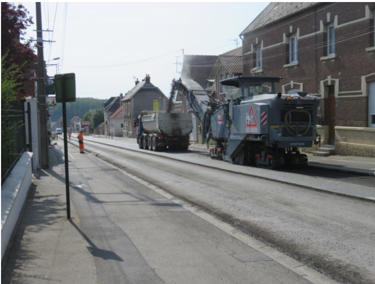
Rabotage de la chaussée
