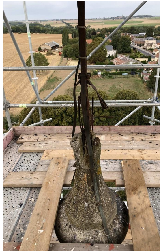
Etat dégradé du béton et des armatures de la pointe du clocher avant travaux
