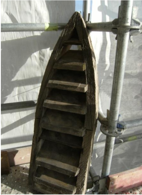
Remplacement des abat-sons et recouvrement en zinc
