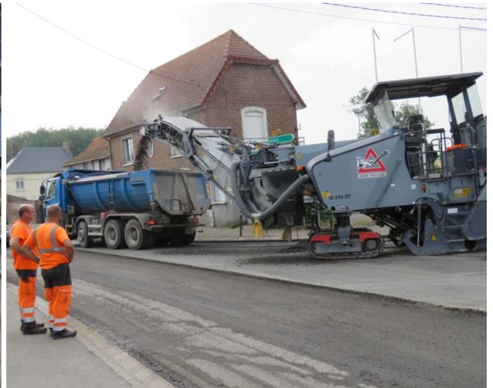
Rabotage de la chaussée
