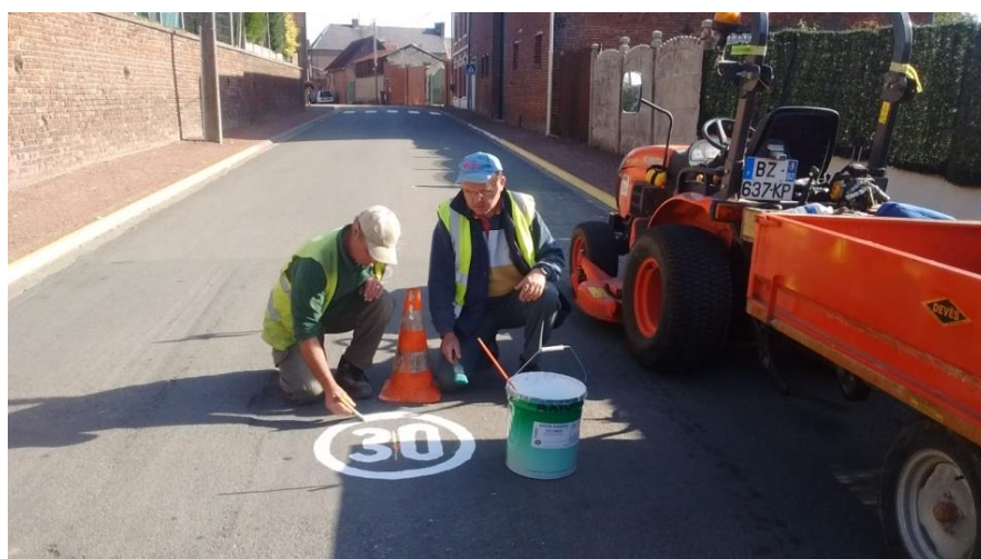
Marquage au sol des zones 30
