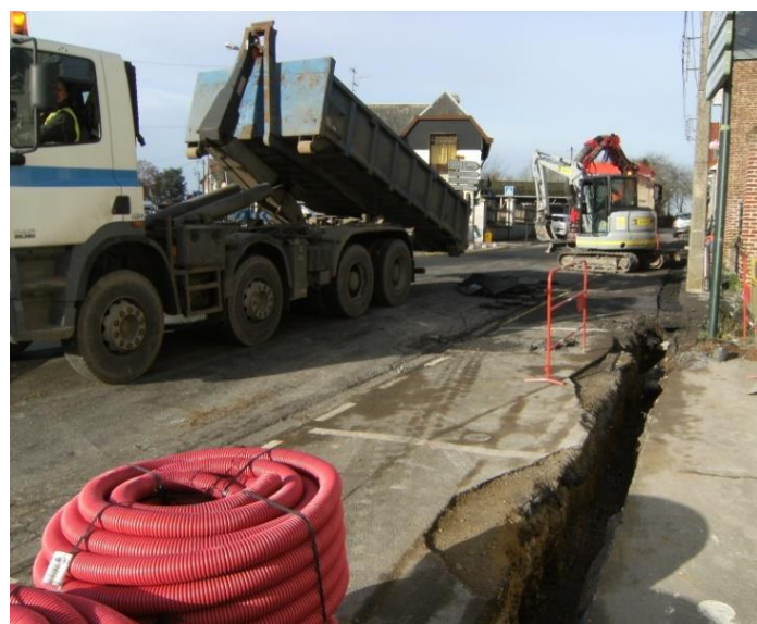
Tranchées pour le passage des fourreaux par forage et aspiration des gravats
