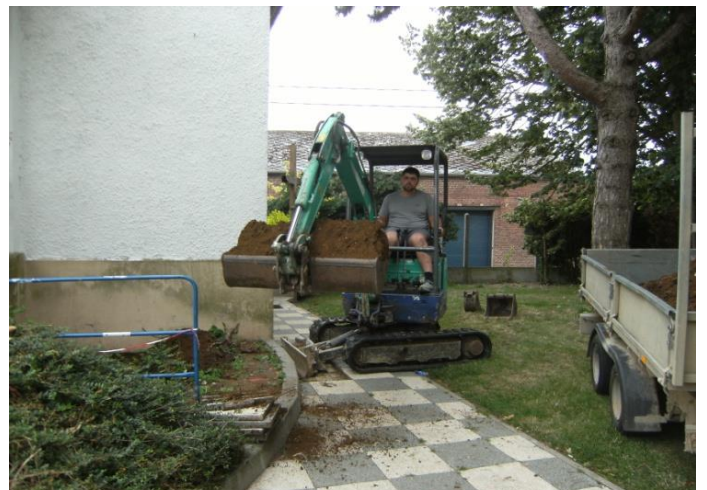
Terrassement des fondations
