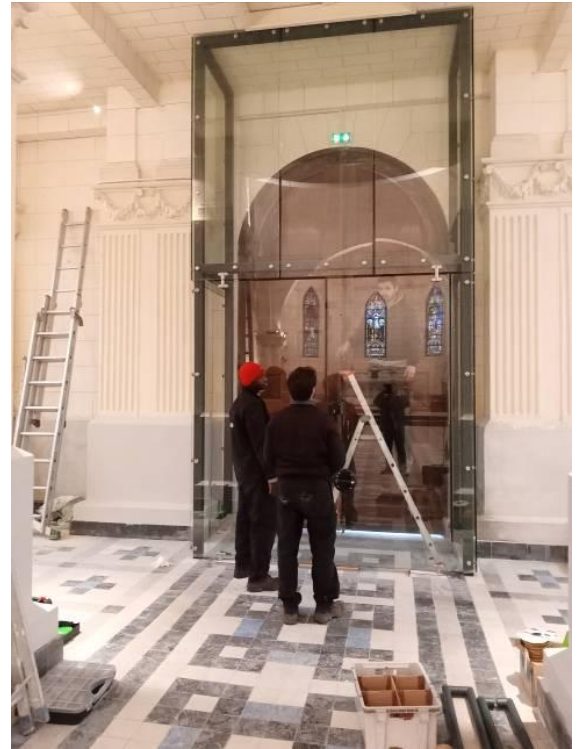
Installation électrique d'un nouvel éclairage et chauffage
