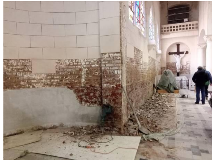
Démolition des soubassements en béton et purge des murs.
