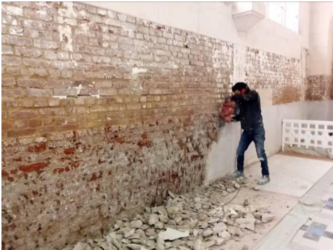
Démolition des soubassements en béton et purge des murs.
