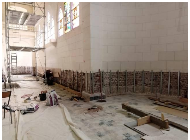
Coffrage et coulage du béton des talonnettes, support du carrelage des plinthes.
