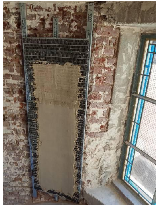
Réfection des enduits des tourelles sur ossature métallique
