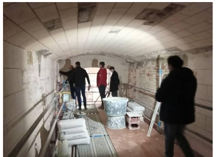
Réfection des voûtes et des murs.
