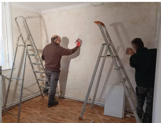
Rénovation de la maison 56 rue André Mercier
