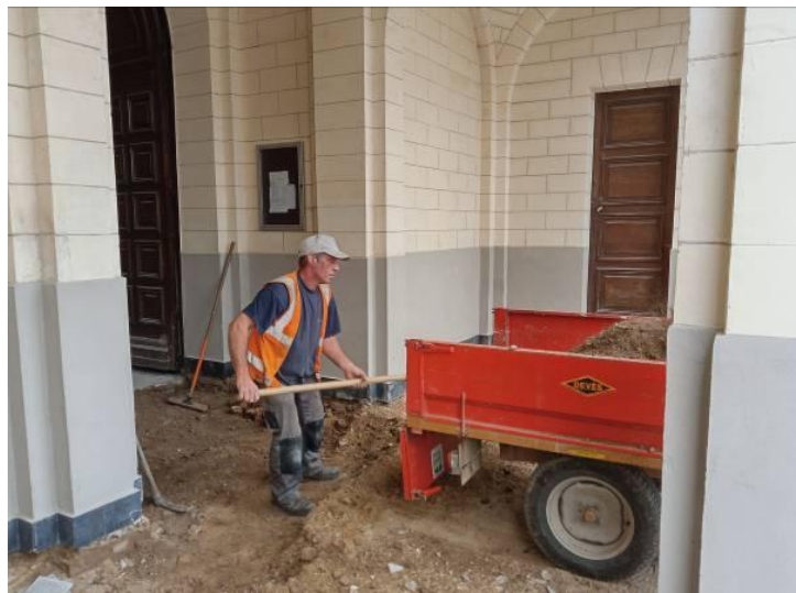
Terrassement du porche et reprise partielle à l'intérieur suite à l'affaissement des sols
