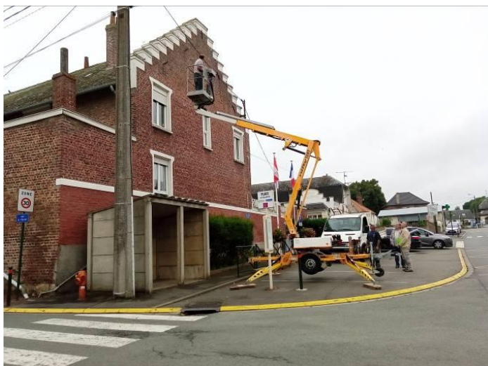
Entretien de la toiture, 1 place Jules Viseur
