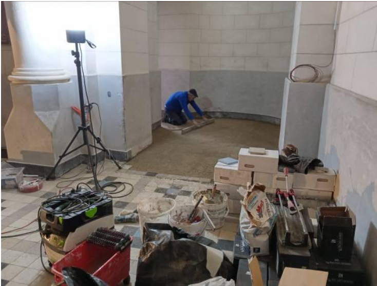
Pose du nouveau carrelage identique à l'ancien, au niveau de l'entrée et des autels.
