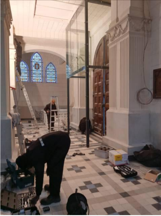
Implantation d'un sas vitré à l'entrée.
