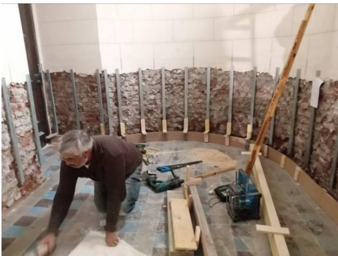
Coffrage et coulage du béton des talonnettes, support du carrelage des plinthes.
