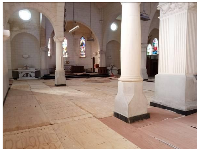
Pose de plaques de contreplaqué pour la protection du carrelage.
