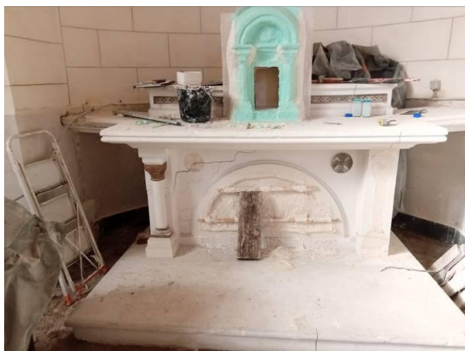
Moulage de l'autel dédié à la Ste Vierge avant démolition
