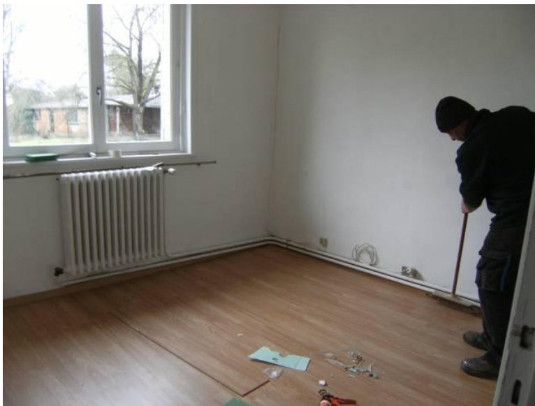
Réfection des murs et plafonds, peinture, pose de parquet.
