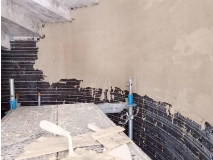
Réfection des enduits des tourelles sur ossature métallique
