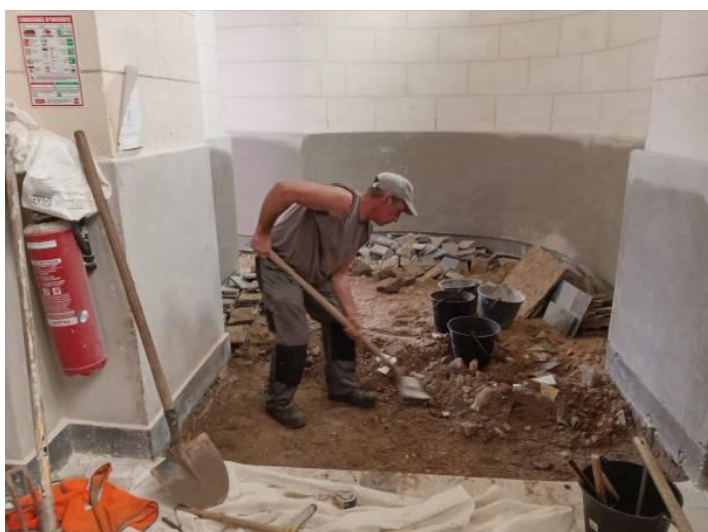
Terrassement du porche et reprise partielle à l'intérieur suite à l'affaissement des sols
