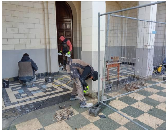
Pose du nouveau carrelage sous le porche suivant les mêmes motifs intérieurs
