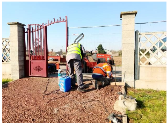
Réfection du portail d'entrée.
