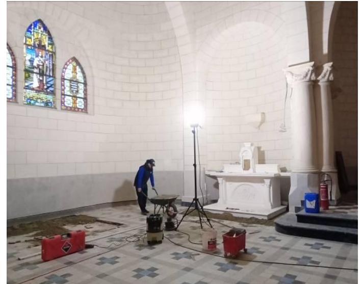
Pose du nouveau carrelage identique à l'ancien, au niveau de l'entrée et des autels.
