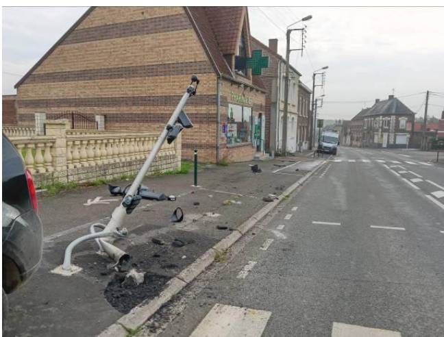
Remplacement du feu tricolore après l'accident de la route.
