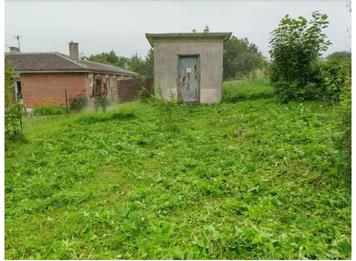
Entretien d'un nouvel espace vert suite à l'achat de l'ancien transformateur, rue André Mercier à l'entrée de l'aacglomération en provenance d'Arras.
