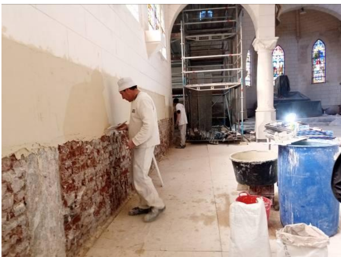
Réfection des enduits sur les murs et des soubassements.
