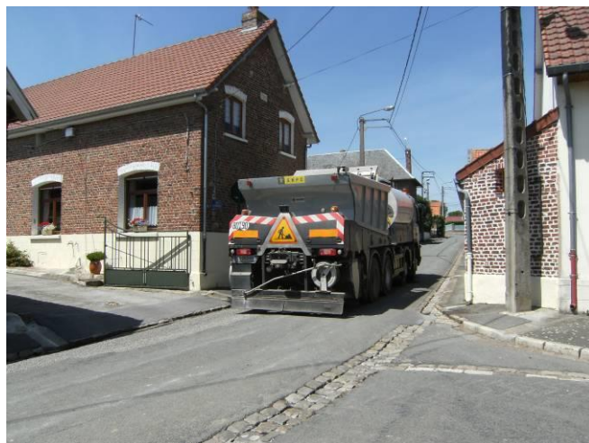
Réparation et gravillonnage rue du 19 mars
