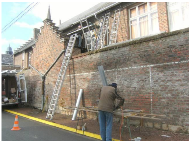
Travaux de zinguerie et descente d'eau rue de l'église
