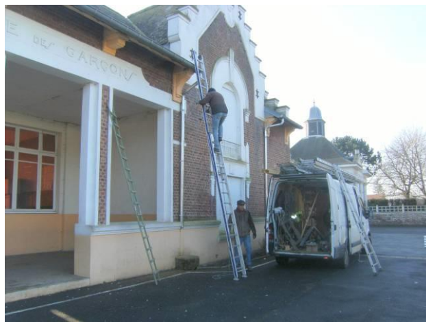
Travaux de zinguerie logement dans la cour des écoles
