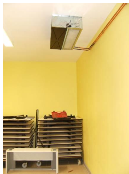
Nouvel aérotherme dans la salle de rangement derrière la scène.
