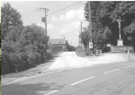
Le calvaire avant les travaux de 2012
