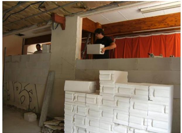
*Maçonnerie du mur de séparation de la salle polyvalente avec le local de rangement*
