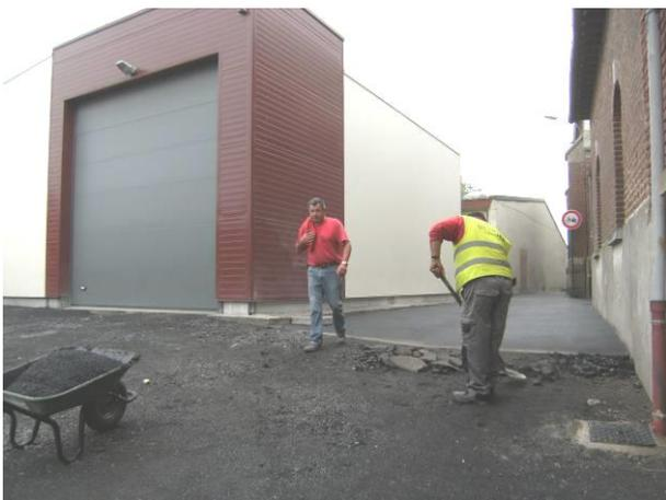
*Réalisation de la forme et pose d'enrobés*
