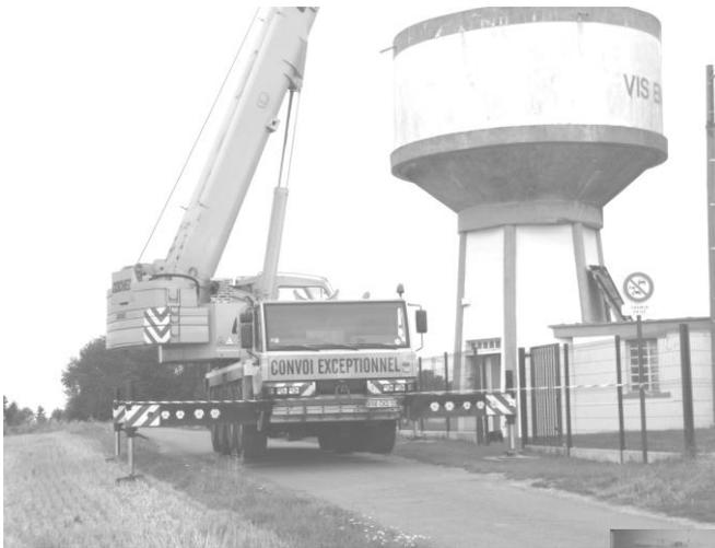
*La pompe d'origine a été remplacée par une pompe immergée qui a nécessité l'enlèvement de toute la colonne d'eau au moyen d'une grue télescopique.*
