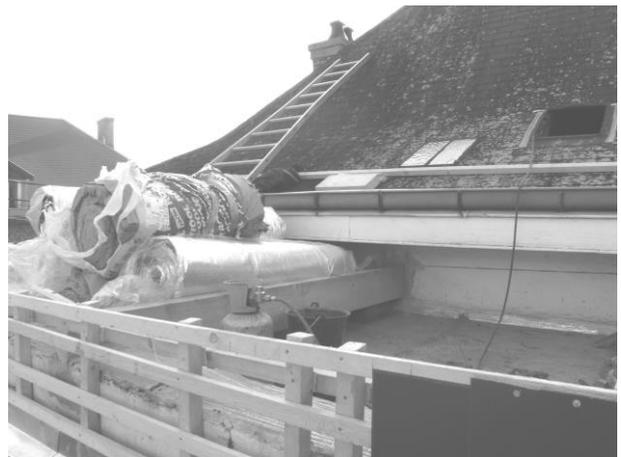
*Couverture de la toiture terrasse pour une toiture à pente en bac acier et habillage de l'acrotère en ardoise.*
