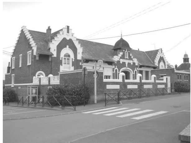
Pose de barrières tout le long du trajet conduisant les enfants au bus scolaire.
